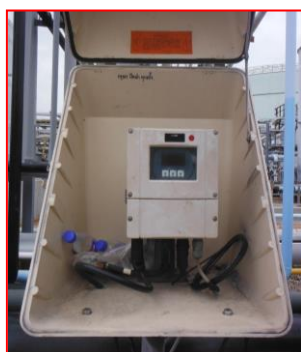
(27) Conductivity Online Analyzer บริเวณก่อนระบบ ออกนอกโครงการ
