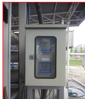
(26) Conductivity Online Analyzer บริเวณระบบ RO
