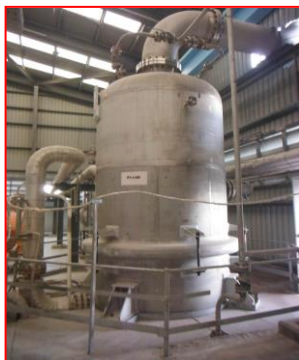
(9) Scrubber และ Condenser บริเวณ PTA Dryer Scrubber
