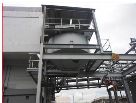
(35) ถัง 10 ตันรวบรวมกากตะกอนจาก ระบบบำบัดน้ำเสีย
